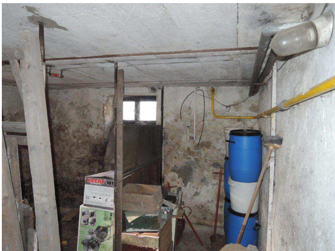
Foto č.10 –Sklep – vlhké stěny s plísní na povrchu
