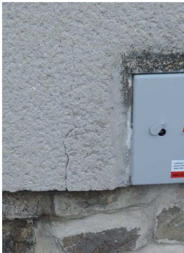
Foto č.4 – Pohled na západní část fasády – praskliny do 3mm
