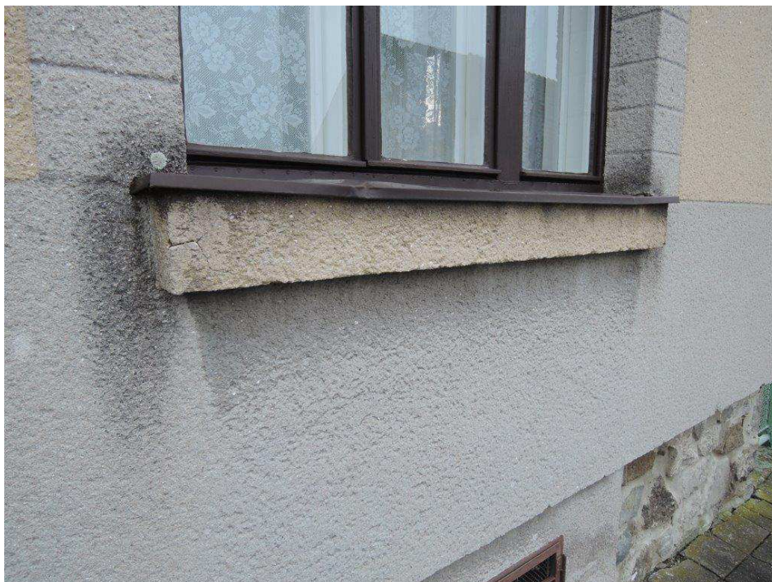
Foto č.7 – Pohled na západní část fasády – praskliny v římsě
