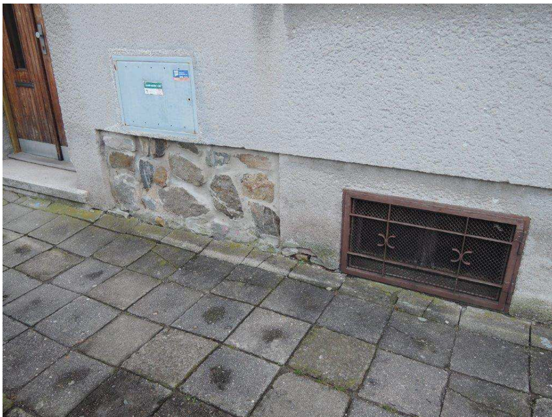
Foto č.6 – Pohled na západní část fasády – drobné praskliny v kamenném základu
