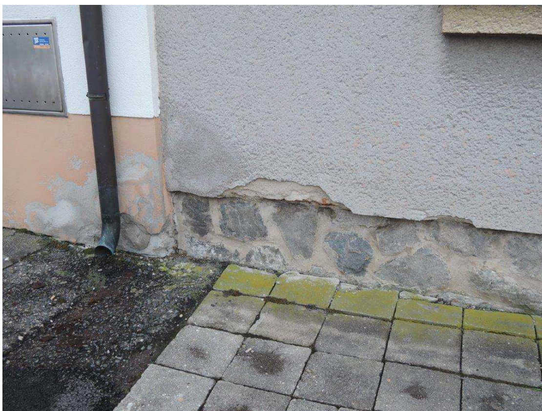
Foto č.5 – Pohled na západní část fasády - opadaná omítka
