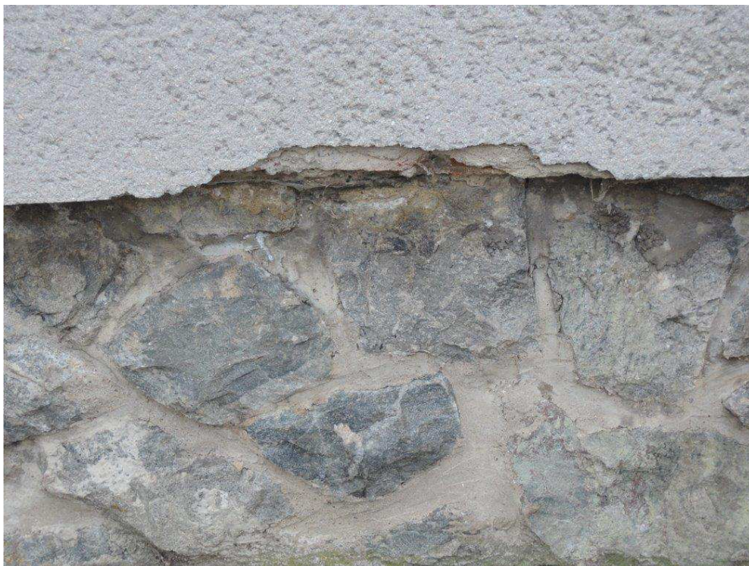
Foto č.2 – Pohled na západní část fasády – opadaná omítka
