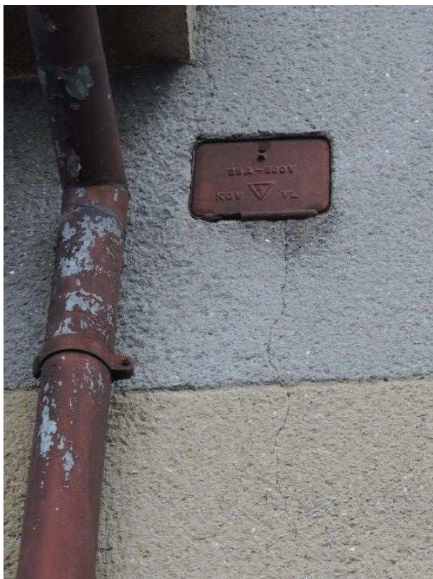
Foto č.3 – Pohled na západní část fasády – praskliny do 3mm
