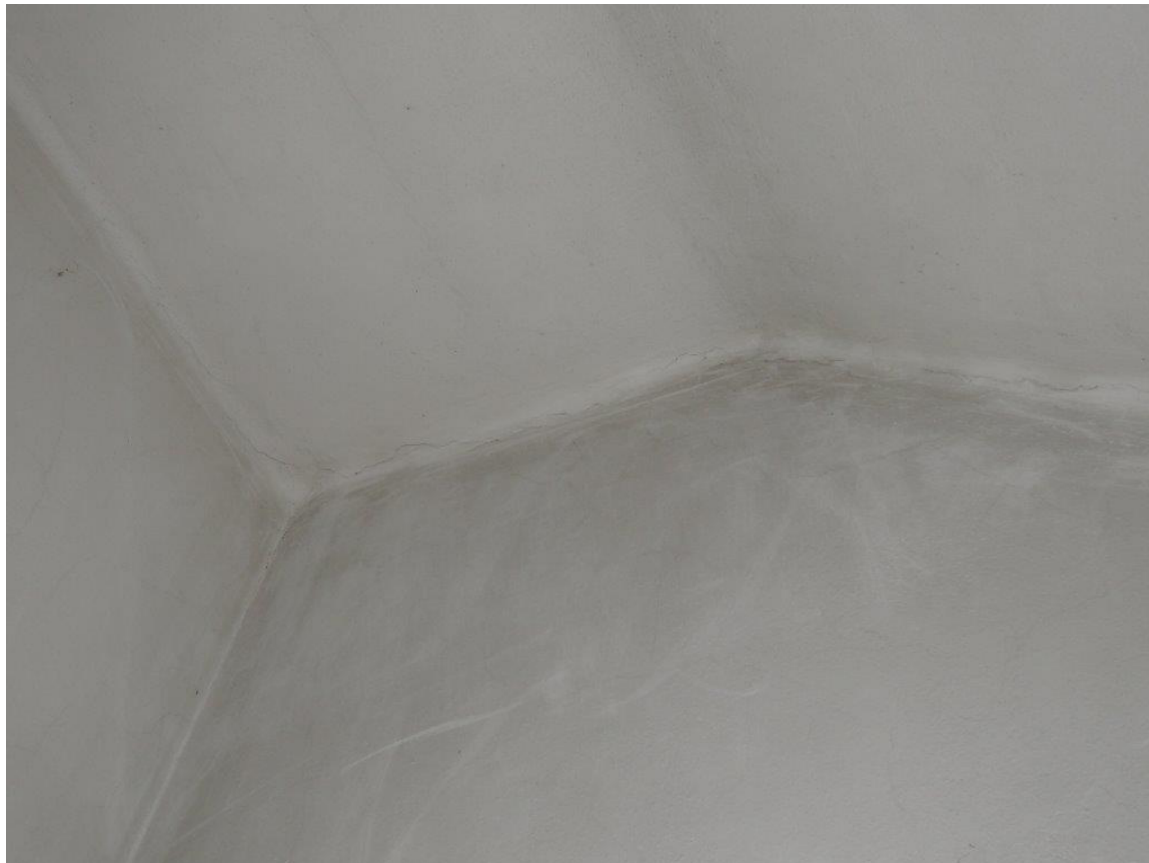
Foto č.14 - chodba do 2.NP - prasklinky v přechodu stěny a stropu
