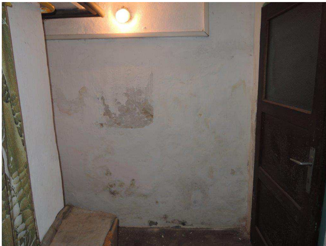
Foto č.11 –Sklep – vlhké stěny s plísní na povrchu
