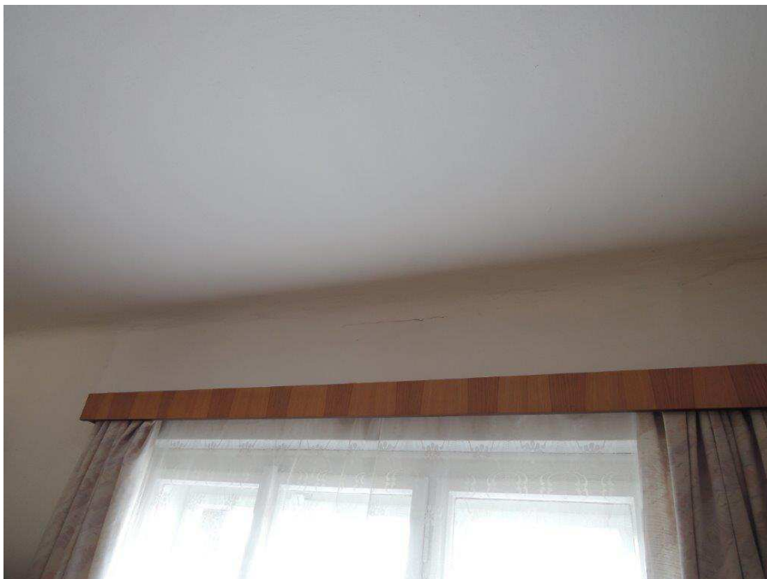
Foto č.12 - prasklinky v přechodu stěny a stropu
