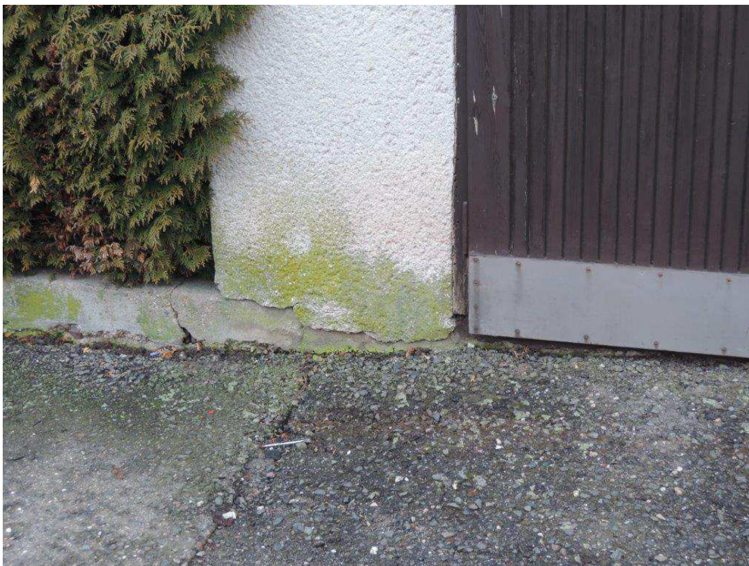
Foto č. 1 - založení garáže na betonové podezdávce oplocení
