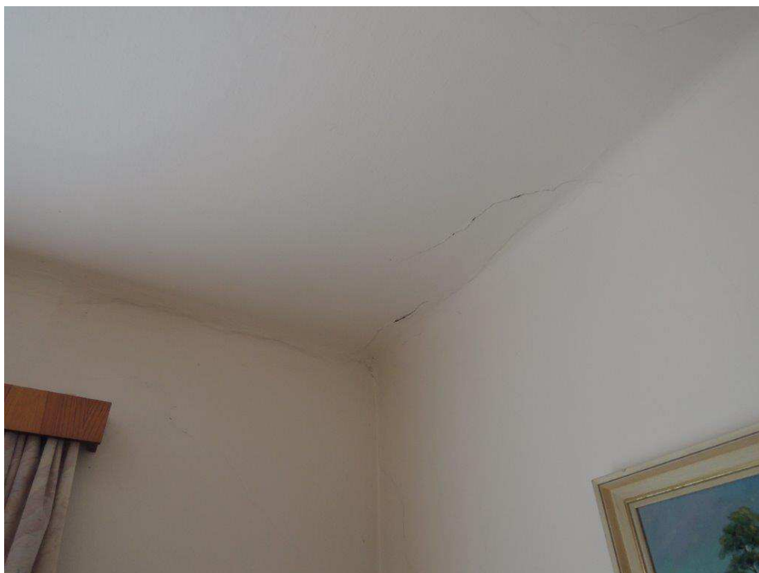
Foto č.13 - prasklinky v přechodu stěny a stropu
